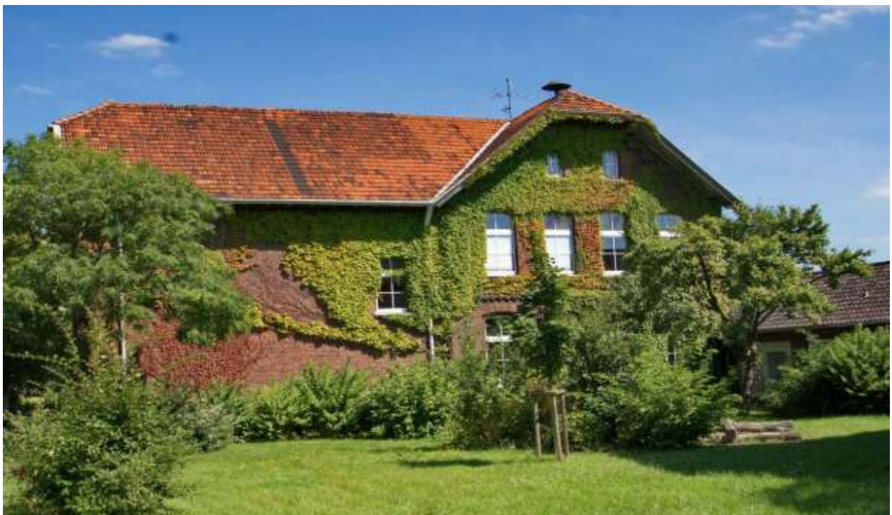
ehemalige Grundschule Ossenberg
