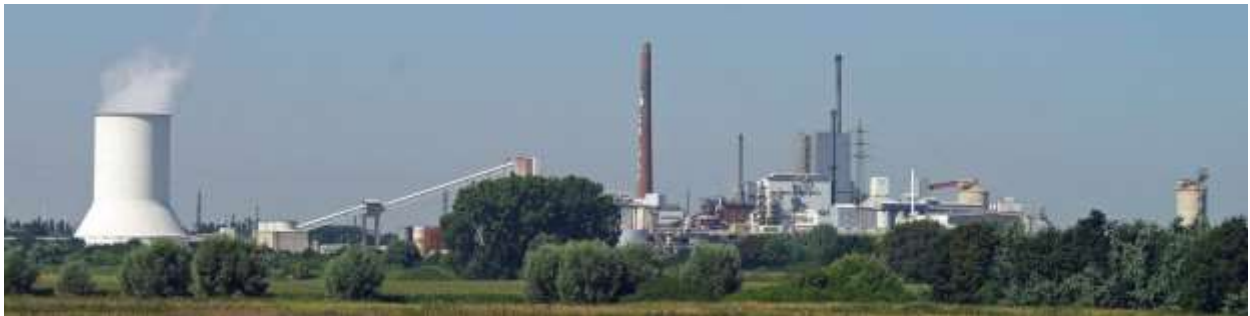
Blick auf die Solvay Werke
